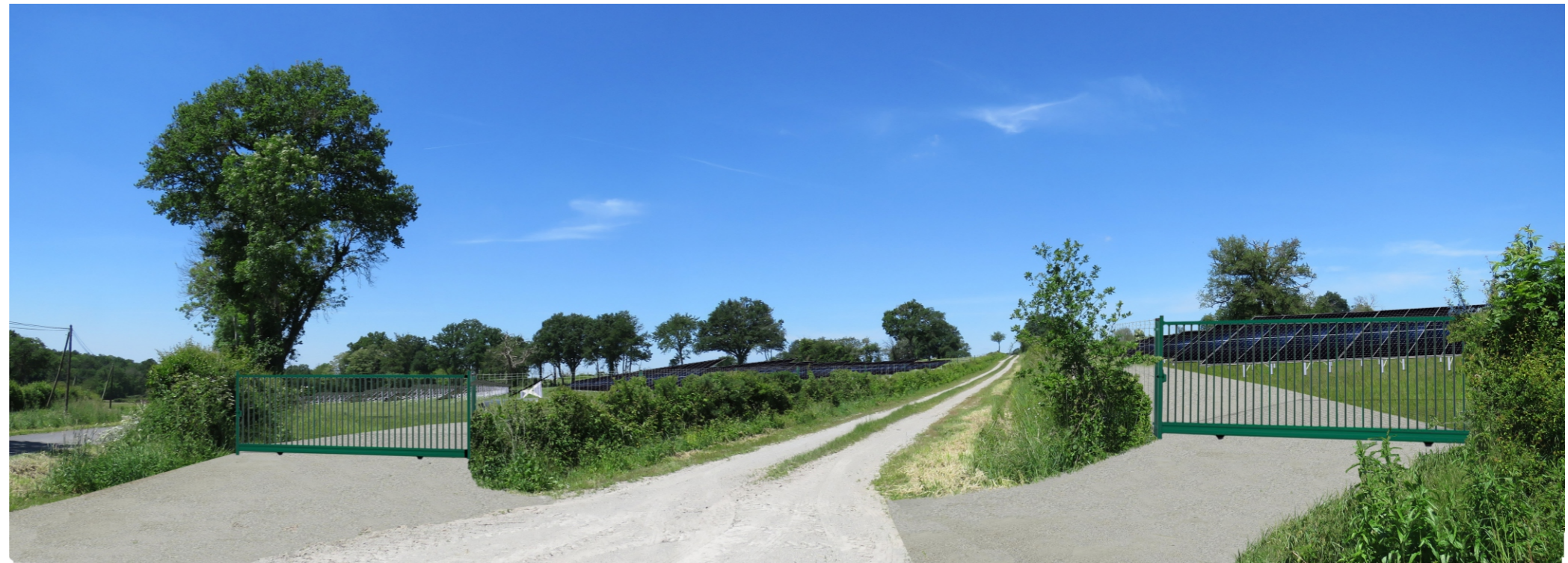
Etat final du site
